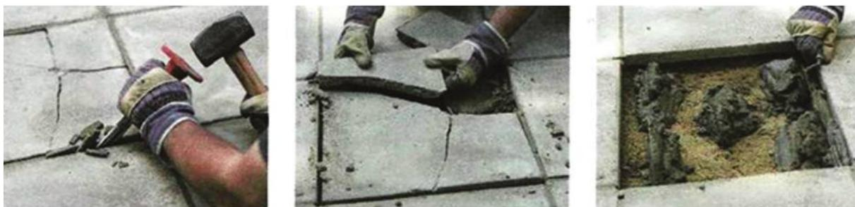
**Рисунок 14.** Ремонт покрытия на пескоцементном подстилающем слое
