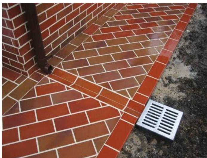
**Рисунок 38.** Сброс воды с крыши в ливневую канализацию.
