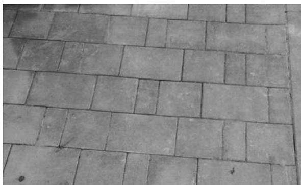
**Рисунок 28.** Покрытие с высолами на пескоцементном подстилающем слое.
